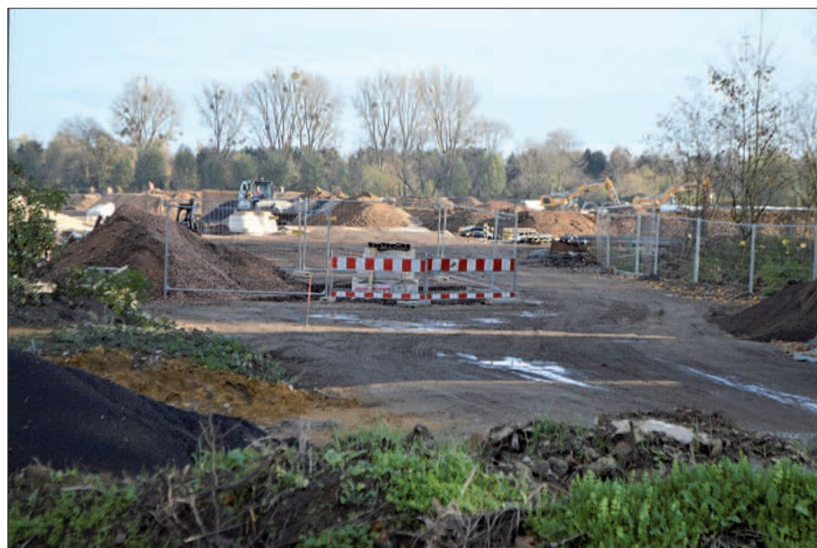
Im Neubaugebiet am Alten Angerbach in Huckingen läuft die Erschließung auf Hochtouren. Alle Straßen sollen nach Frauennamen benannt werden. Text u. Foto: sam
