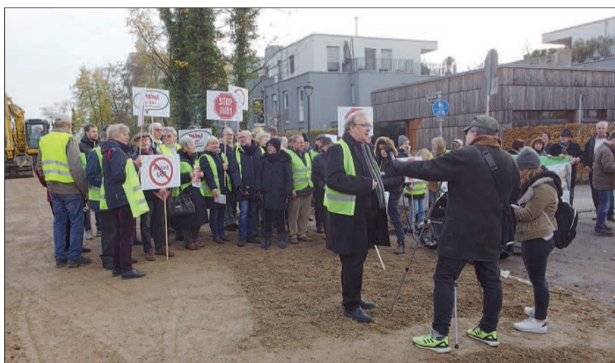
Protestdemonstration auf der U 81-Baustelle an der Lilienthalstraße. Foto: H.S.
