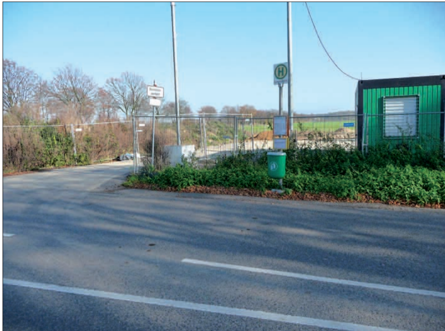
Ersatzhaltestelle „Kalkumer Schlossallee“, Fahrtrichtung Wittlaer, auf der Fahrbahn, mit Brennmesseln im Rücken. Für eine Baustelleneinrichtung ist reichlich Platz, aber nicht für ein Bushaltestelle.
