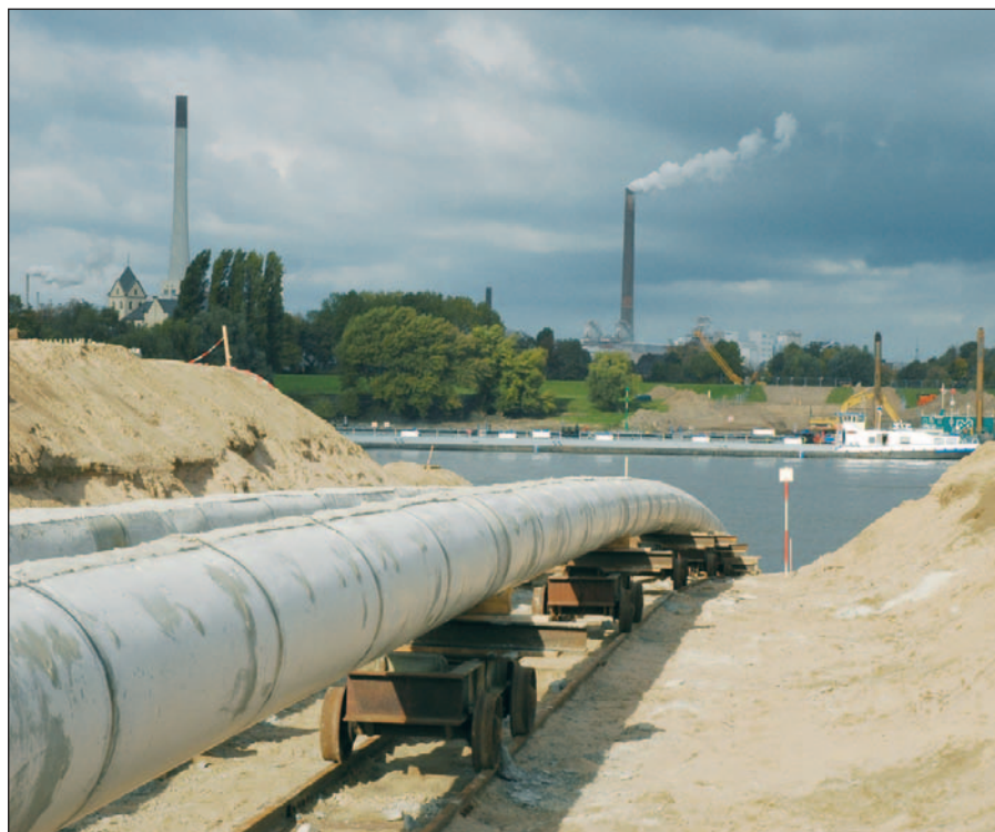
Noch liegen die bereits in einem Schutzmantel aus Beton eingegossenen Mannesmann Fuchs Stahlrohre für die neue Pipeline im Mündelheimer Rheinvorland, wo sie auf ihre Versenkung in den Rhein warten.
