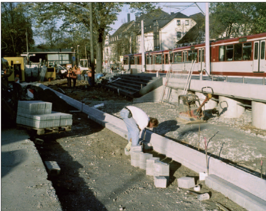
Die Arbeiten an den Hochbahnsteigen auf dem Klemensplatz gehen zügig voran. Im Vordergrund die zusätzliche Busspur auf der Niederrheinstr. Richtung Norden stadtauswärts.
