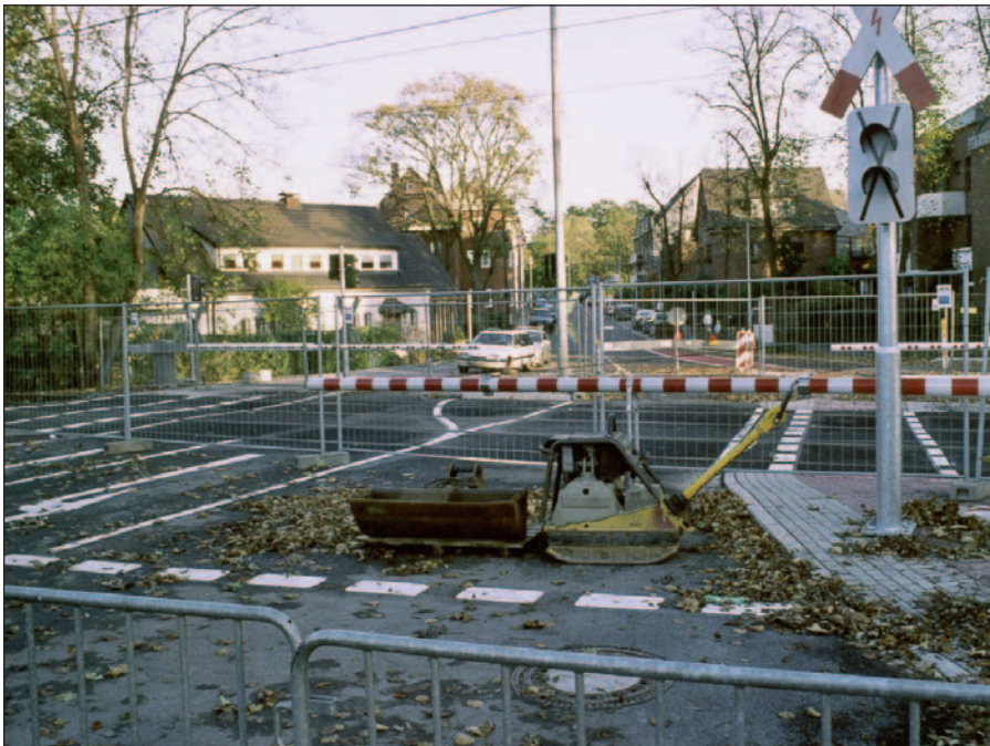
Blick vom Gutshof in die „neue“ Kreuzbergstrasse. Im Vordergrund der mit Schranken und Ampeln gesicherte Übergang über die Schienen der U 79. Die Bauzäune und Baugeräte werden bis zum 14. November abgeräumt.
