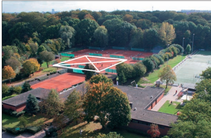
Hier wird sie in wenigen Tagen stehen: die Traglufthalle für die LSV-Tennisabteilung
