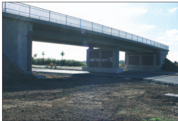
Noch steht die Brücke an der Anschlussstelle B8n einsam in der Landschaft. Foto & Text: GS
