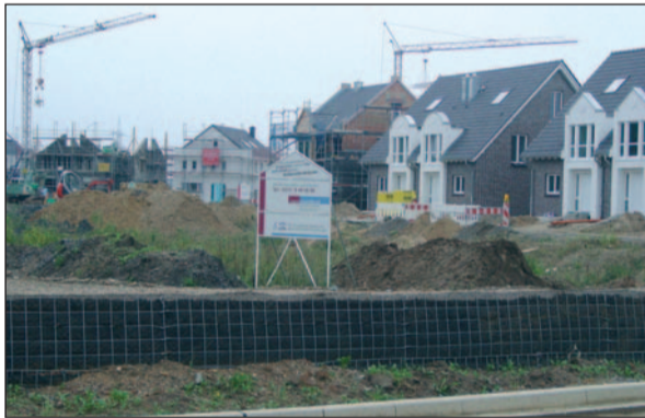
Angesichts des großen Baugebiets ist eine Jugendfreizeiteinrichtung unverzichtbar. Foto & Text: GS
