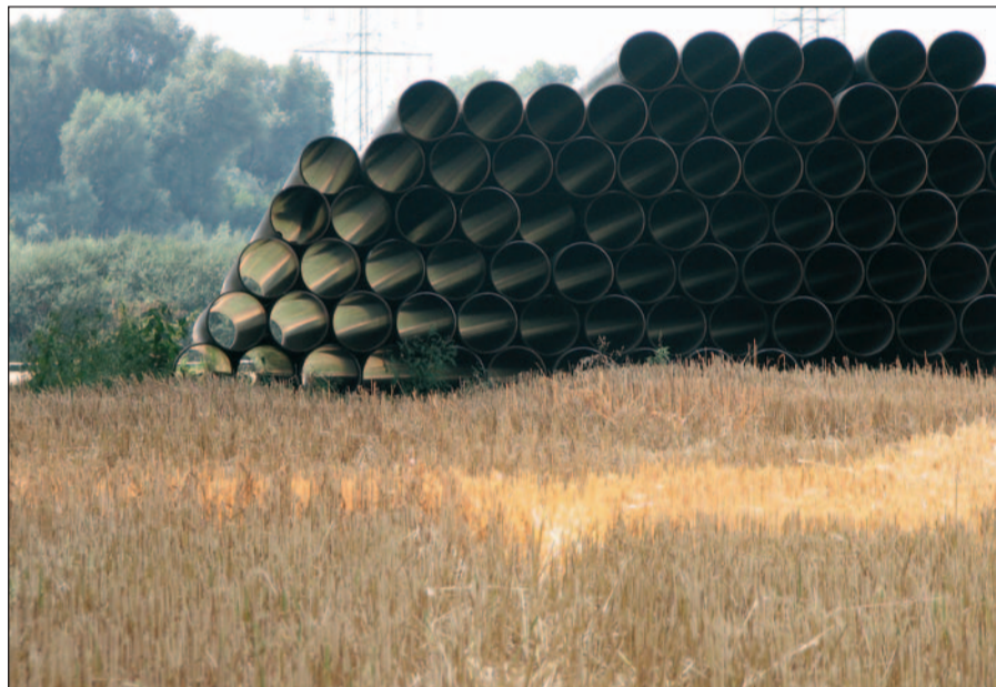
Noch liegen die Rohre für die Pipeline im südlichen Stadtrand Duisburgs über der Erde.
