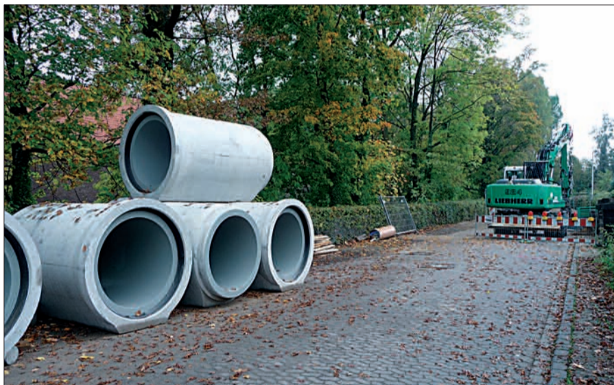
Kanalbauarbeiten in Kalkum zwischen Kirche und Schloss.
