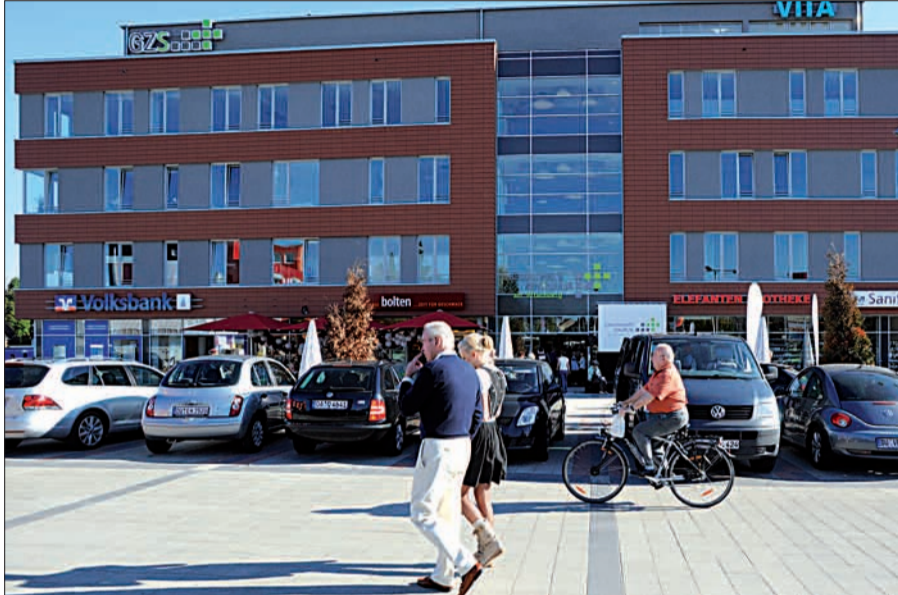
Das neue Gesundheitszentrum am Sittardsberg präsentierte sich nach einer Bauzeit von 14 Monaten am Tag der offenen Tür bei bestem Wetter.
