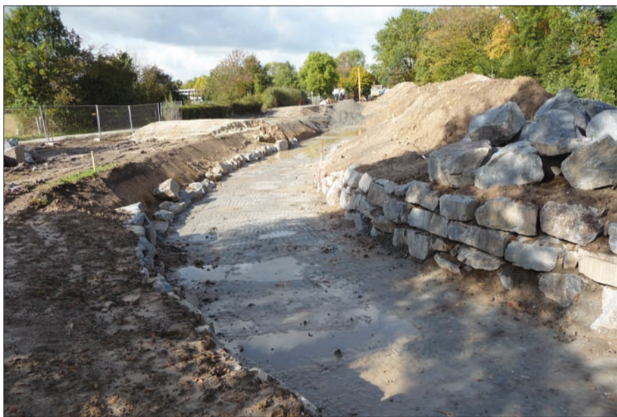
Das noch trockene Bachbett der neuen Anger in Angermund.
