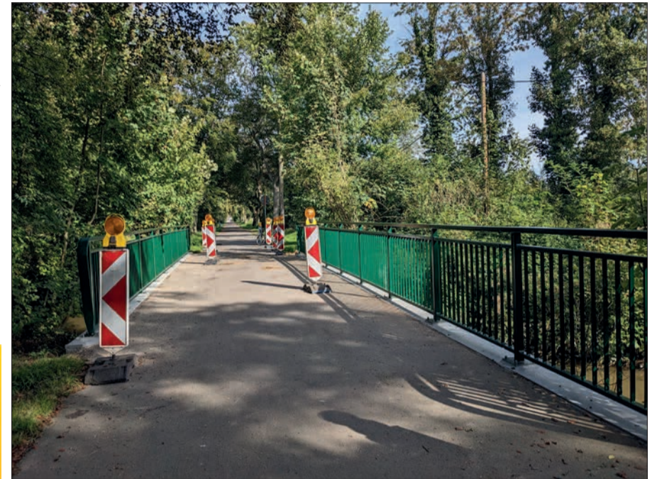
Fertig ist das neue Brückengeländer, das über die Anger führt, an der Heltorfer Schlossallee. Foto: GS
