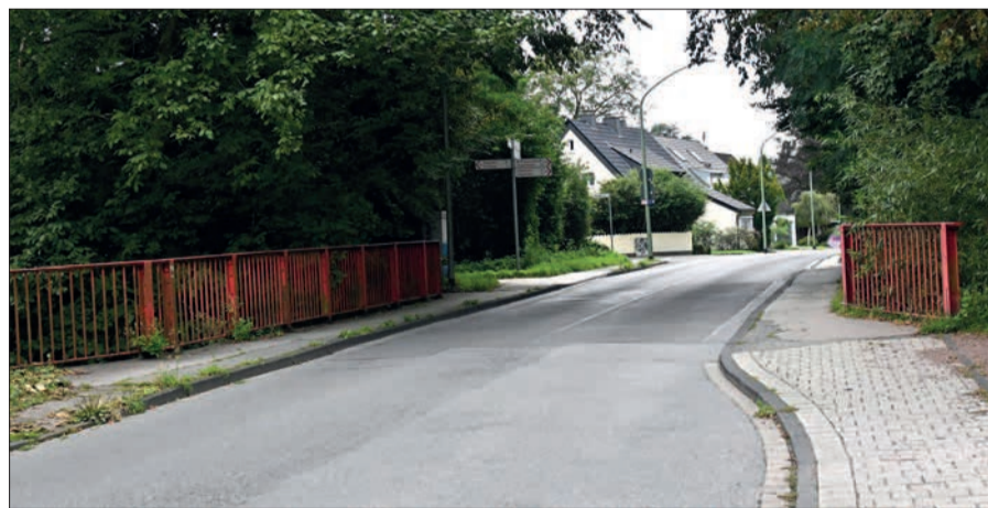
Die Brücke über den Angerbach an der Straße Am Heidberg in Ungelshelm steht auf der Prioritätenliste, die demnächst im Rat verabschiedet werden soll. Foto: sam
