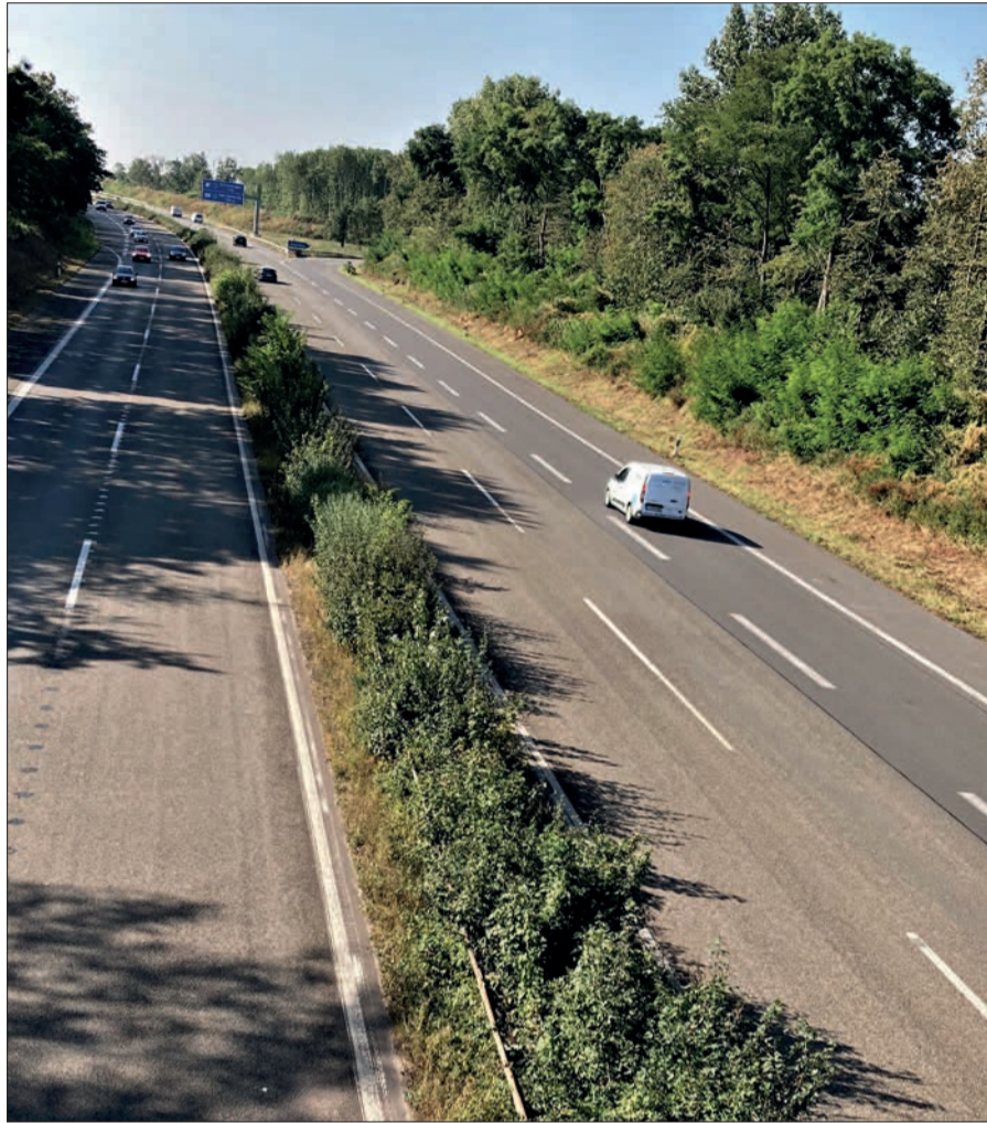
Die Strecke von Breitscheid nach Rahm auf der A 524 kann man derzeit ohne Tempobegrenzung befahren. Der Bürgerverein fordert den OB auf, sich für „Tempo 80“ einzusetzen - 500 Meter vor der Abfahrt Rahm in beiden Richtungen. Foto: sam
