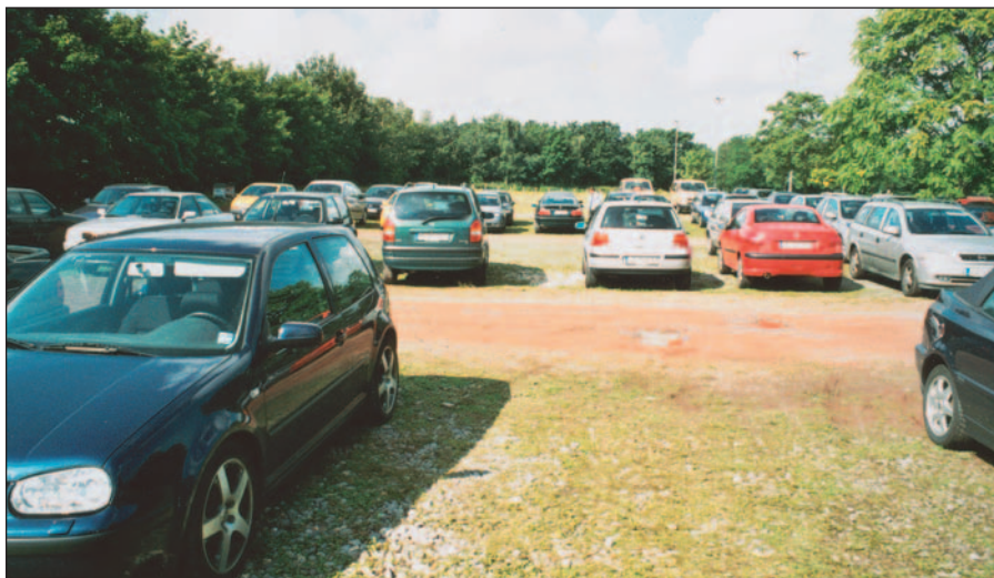
Auf diesem Personalparkplatz in der südwestlichsten Ecke des Flughafens soll in den nächsten Jahren die „Feuerwache Nord“ für die Berufsfeuerwehr errichtet werden. Sie wird vor allem für die Stadtbezirke 5 und 6 zuständig sein. Der Nordstern befindet sich direkt hinter den Bäumen links.
