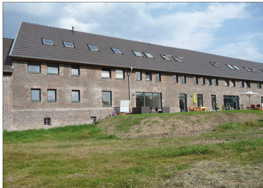
Aus Haupthaus und Wirtschaftsgebäuden des ehemaligen Rittersitzes Kaldenberger Hof ist eine wunderbare Wohnanlage geworden. Hier ein Blick auf die Südostseite. Foto: HS
