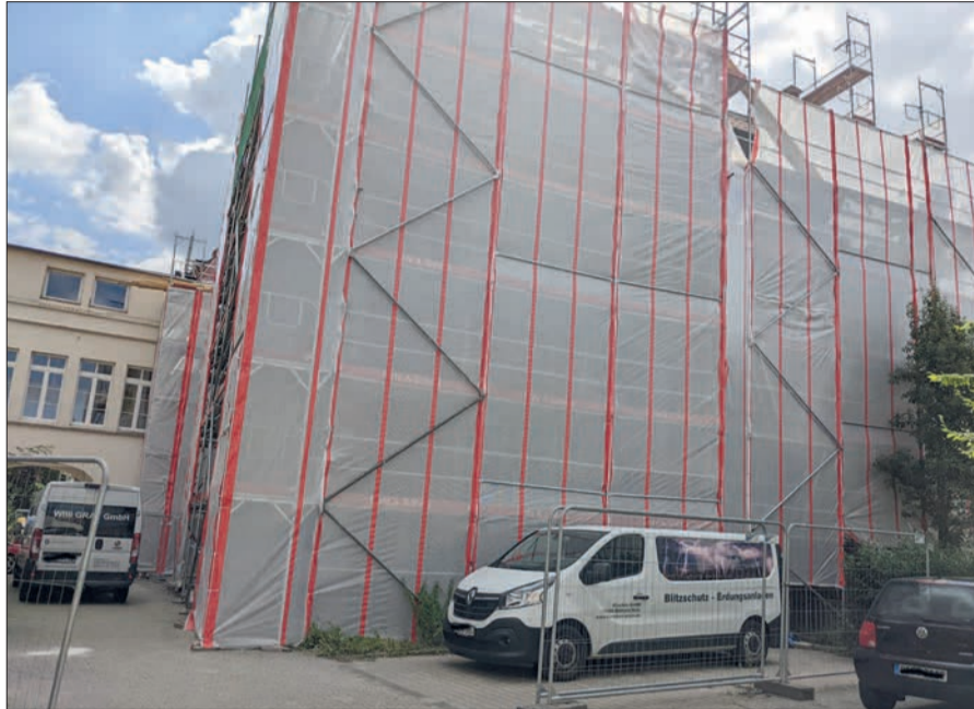
Verhüllt wie bei Christo ist das Antoniushaus in Kaiserswerth, dessen Umbau und Sanierung begonnen haben. Foto: G.S.
