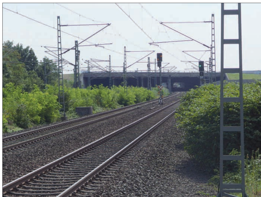
Ein Bauwerk, wie das ohne Unterbrechung von Bahn- und Luftverkehr errichtete „Flughafenschutzbauwerk“, sollte Angermund vor Bahnlärm schützen können und schafft noch zusätzliches, wertvolles Bauland. Foto: H.S.
