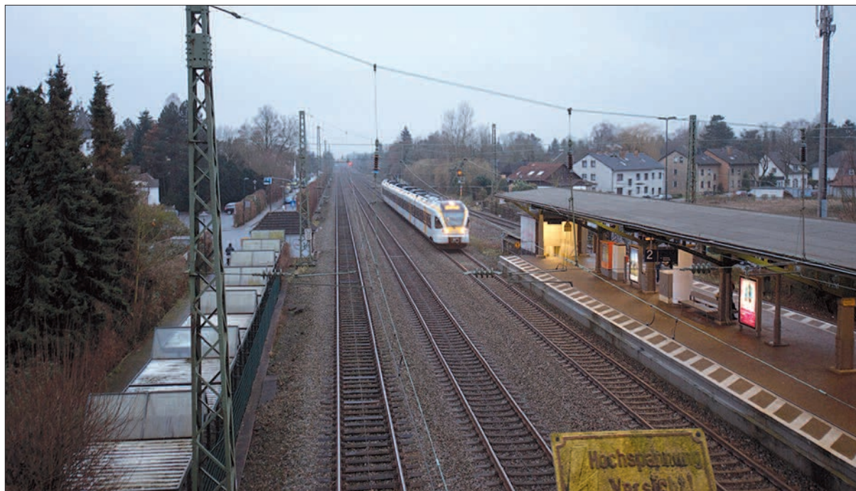
Das Foto zeigt den S-Bahn Halt Angermund sowie die Zerschneidung des Stadtteils durch die bestehenden vier Gleise. Foto: Privat
