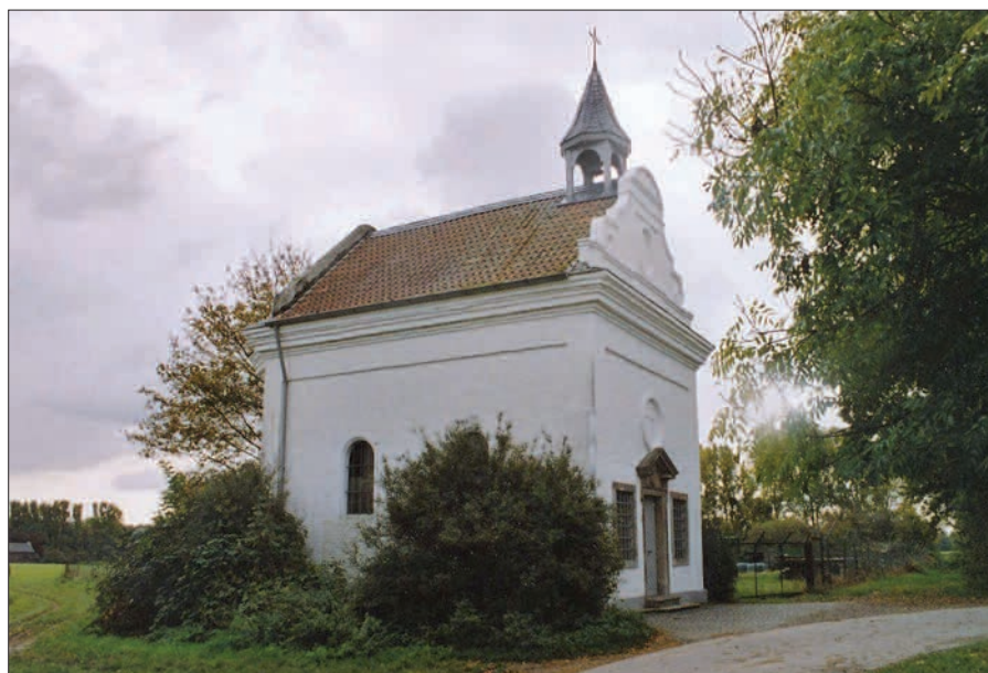
Die Winkelhauser Hubertuskapelle vor Beginn der Sanierungsarbeiten.
