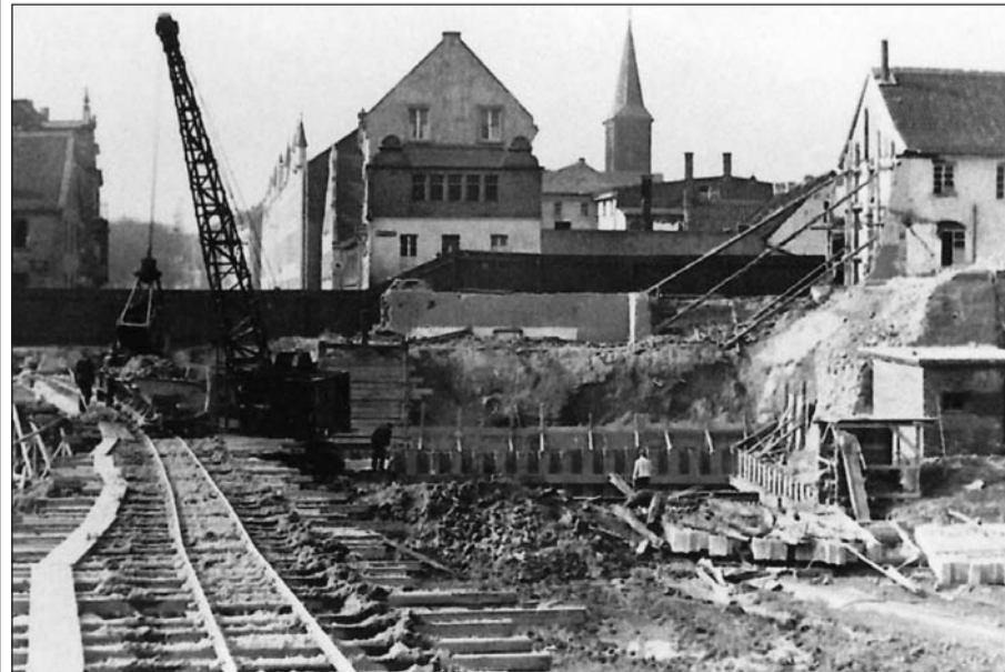
Bau des Hochbunkers und Erneuerung der Klemensbrücke in den Jahren 1941/42.
