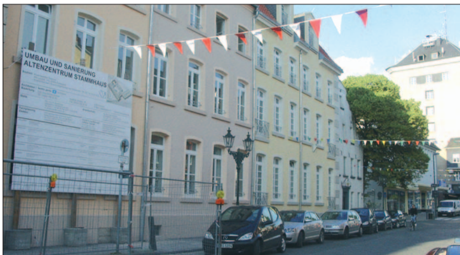
Kurz vor der Sanierung steht der erste Bauabschnitt des Kaiserswerther Stammhauses
