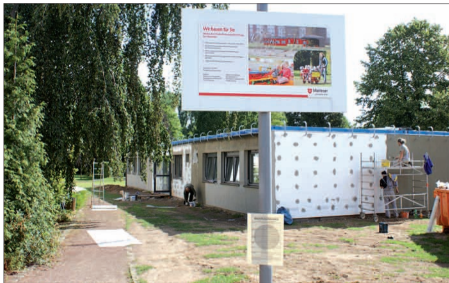
Der Neubau für die Großtagespflege wird in Modularbauweise eingeschossig errichtet und ist schon gut zu erkennen. Betreiber ist die Malteser St. Anna gGmbH, Träger der Verein „Die Spielmäuse e.V.“. Fotos: sam
