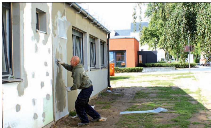
Handwerker legen außen noch den letzten Schliff an. Im Hintergrund ist die HNO-Ambulanz des Krankenhauses in Huckingen zu erkennen.
