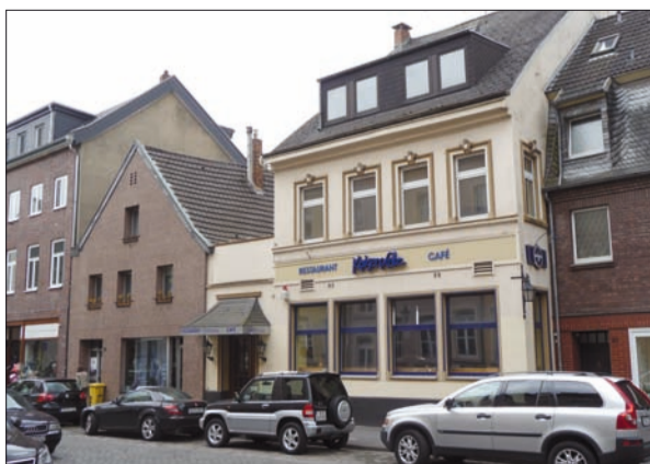
Für Haus Nr. 45 und 43 am Kaiserswerther Markt sind Abriss und/oder Totalsanierung im Gespräch.
