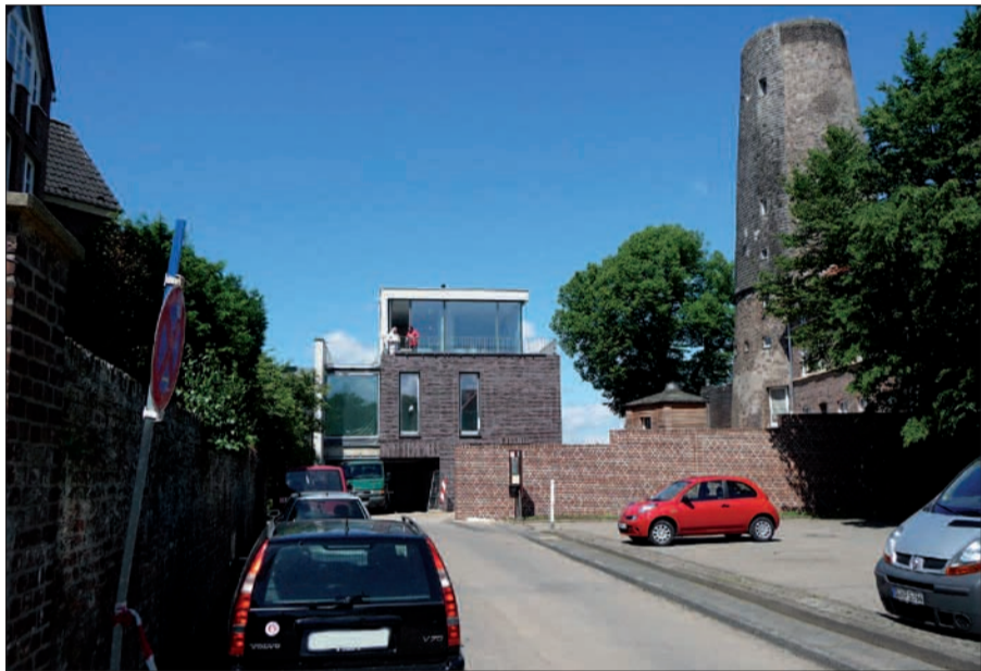
Ein Blickfang in der Fliednerstraße ist das gläserne Obergeschoss der neuen Villa auf der Bastion Maximilian neben dem Mühlenturm in Kaiserswerth. Foto: H.S.
