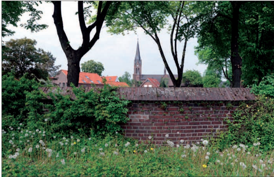
Für den Bereich wo einmal die alte Volksschule von Huckingen, stand liegt nun ein geänderter Bebauungsplan aus. Foto : H.M.
