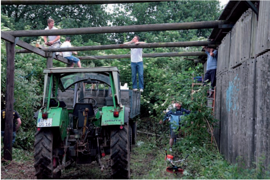
Ein jecker Bautrupps bei Arbeiten in luftiger Höhe
