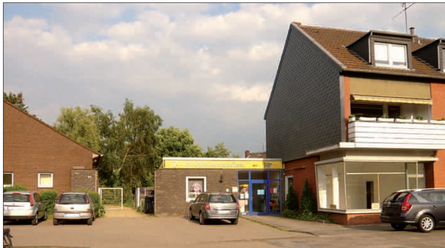
Kindergarten und Dritter Weltladen sind bereits ins Gemeindehaus umgezogen. Jetzt können auch hier die Umbaumaßnahmen zum Familienzentrum beginnen. Foto: H.M.
