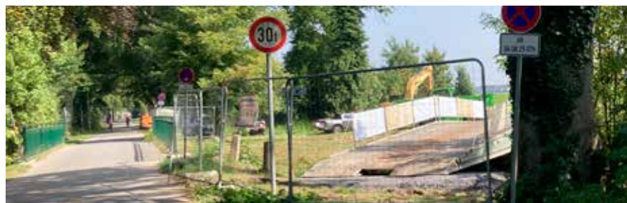
Für Baufahrzeuge wurde eine Behelfsbrücke über die Anger errichtet. Foto: sam
