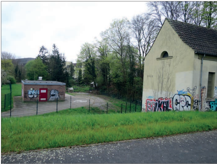
Hinter dem Deich und mit den beiden beschmierten Pumpstationen nördlich Kaiserswerth zeigt die historische Stadt ein weniger schönes Gesicht. Foto: H.S.
