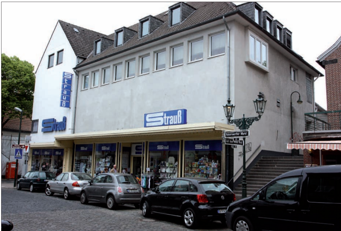
Es steht fest: Das Kaufhaus Strauß wird im Bestand entwickelt zu einer Mischung aus Gewerbe und Wohnen. Im Winter beginnen die Umbauarbeiten. Foto: G.S.
