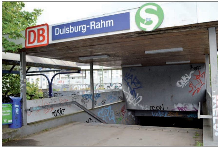
Erst in fünf bis zehn Jahren kann wahrscheinlich mit dem Umbau des S-Bahnhofs in Rahm begonnen werden. Dieser soll dann barrierefrei werden. Text u. Foto: sam
