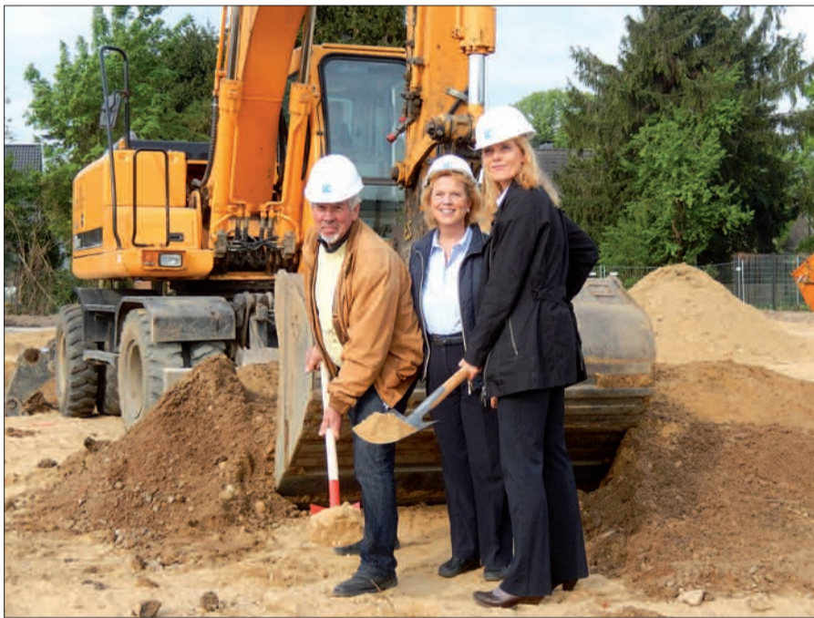
Die Geschäftsführer Herbert Sobota, Margot Stedler und Marieke Stedler (von links nach rechts) beim ersten Spatenstich auf dem Grundstück in der Ikarusstrasse. Foto: Privat
