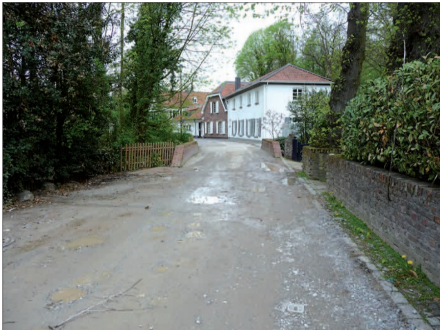
Der Regenwasserkanal auf der Oberdorfstraße ist bereits verlegt, die „Drecklöcher“ sind noch da: Aktueller Zustand der Oberdorfstraße im Bereich der alten Wassermühle und Schwarzbachbrücke. Foto: H.S.
