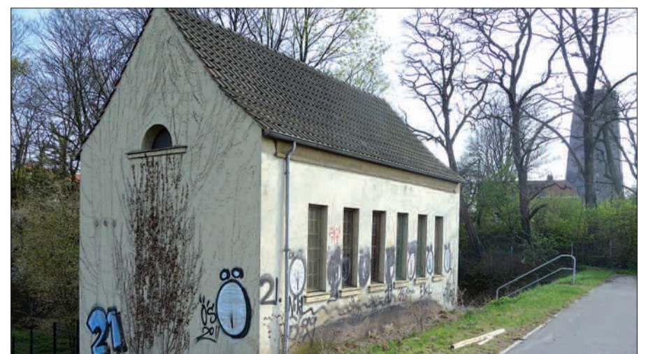
Anstöße, das alte denkmalgeschützte Pumpenhaus auf dem Kaiserswerther Deich sinnvoll zu nutzen, gab es schon vor Jahren. Tatsächlich geschehen ist aber nichts. Foto: H.S.
