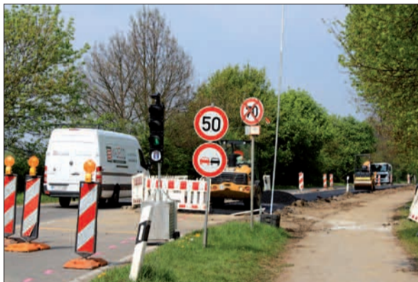
Von wegen Wartezeit an Baustellenampel – hier geht's flott weiter.
