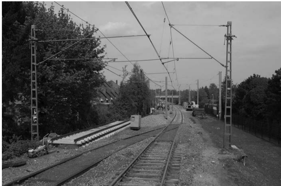
Die DVG lässt die Gleise rund um die Haltestelle St. Anna-Krankenhaus erneuern
