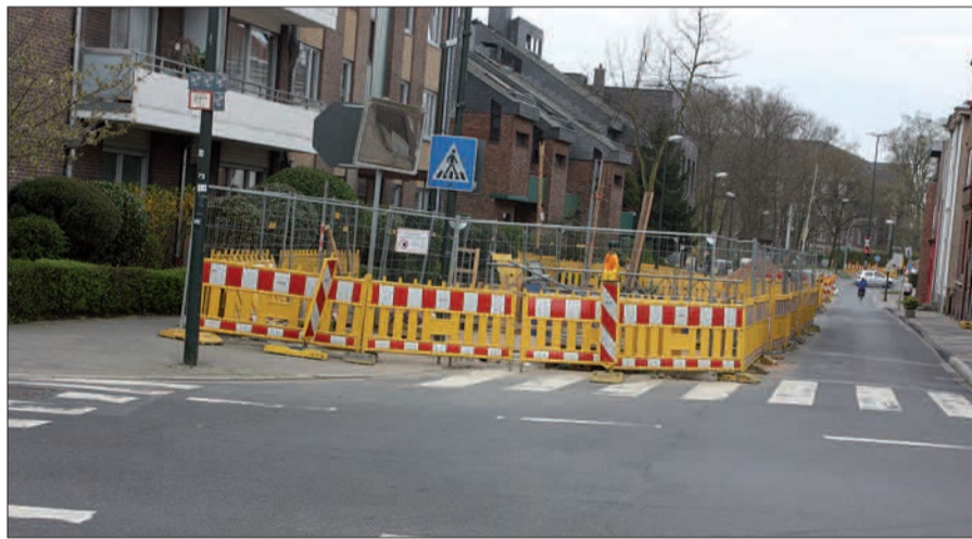
Schon seit vielen Monaten herrscht auf der Kreuzbergstraße/Ecke Arnheimer Straße eine Einbahnregelung, um die Baumaßnahme durchführen zu können. Statt Ende Januar wird es nun Mitte Juni, bis sie fertig gestellt ist und die Druckrohrleitungen vollständig verlegt sind.
