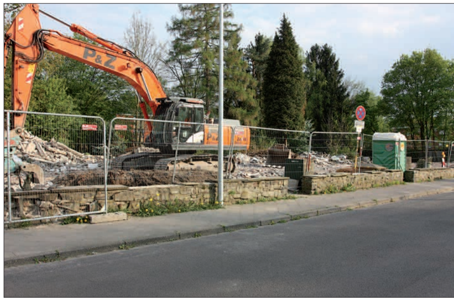
Hier sollen im ersten Bauabschnitt 60 Mietwohnungen unter der Regie der DWG entstehen.
