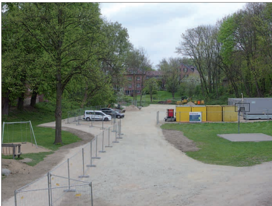
Die Baustelleneinrichtung im Kaiserswerther Wallgraben für einen Abwasserkanal. Foto: H.S.
