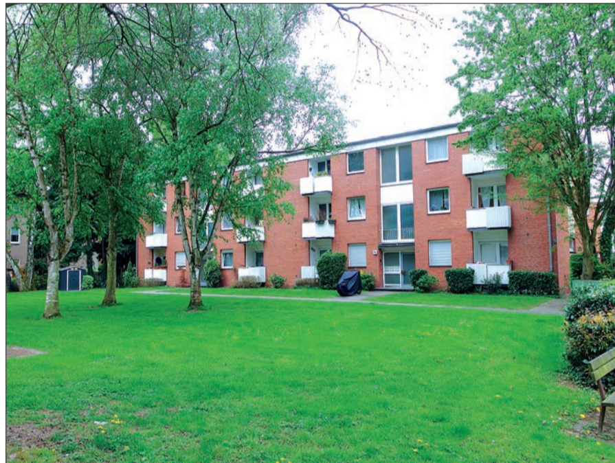
An der Verweyenstraße in Kaiserswerth sind 9 solche Gebäude (4 davon nur 2-geschossig) zwecks Verdichtung und Modernisierung zum Abbruch vorgesehen. Einige ältere Gebäude an der Alten Landstraße sind dieser Tage bereits den Baggern zum Opfer gefallen. Foto: H.S.
