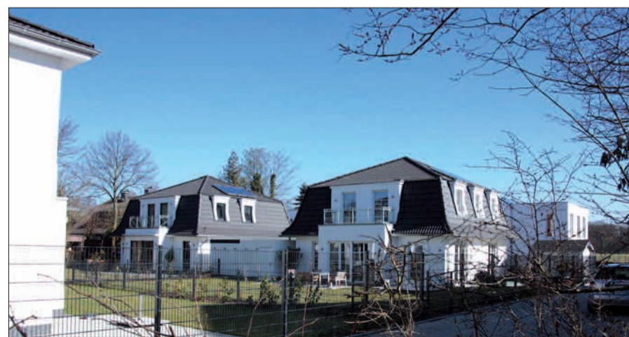
Diese Häuser sind ein Beispiel für gelungene Planung mit einer Mindestgrundstücksgröße von 500 qm. Foto: G.S.
