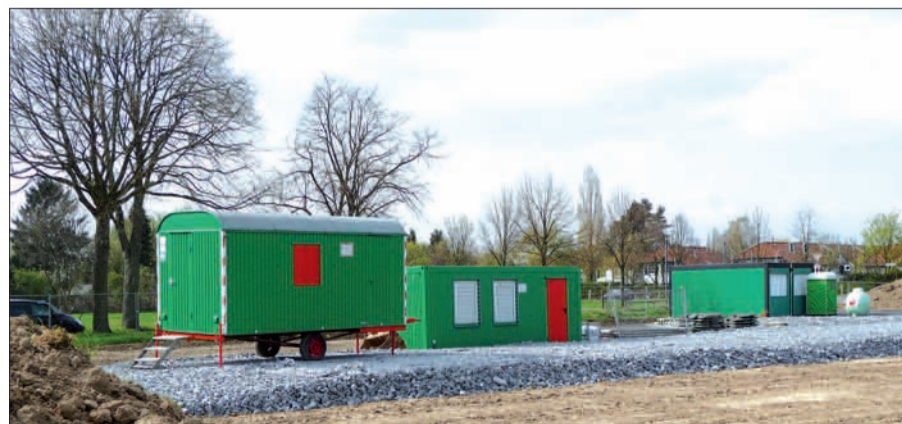
Die schon vor Wochen aufgebaute, großzügige Baustelleneinrichtung auf dem Schlossacker gegenüber dem Kalkumer Schützenplatz lässt ahnen, dass auf Kalkum einiges an Kanalbauarbeiten zukommt. Ein sauberer Schwarzbach sollte aber die Beeinträchtigungen aufwiegen.
