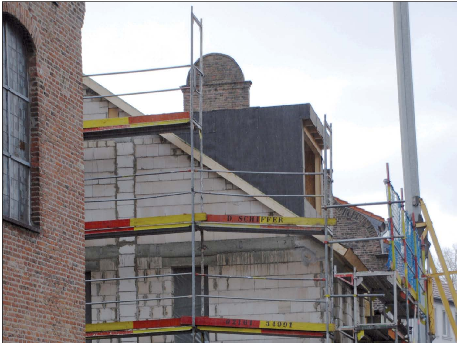
Der Neubau im Dezember 2008
