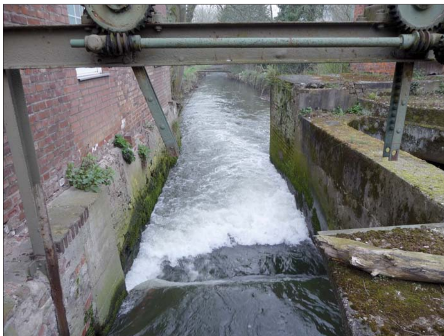
Die Beseitigung des Engpasses an der Wolfschen Mühle mitten in Angermund ist einer der aufwendigen Arbeiten beim Ausbau der Anger. Text u. Foto: H.S.
