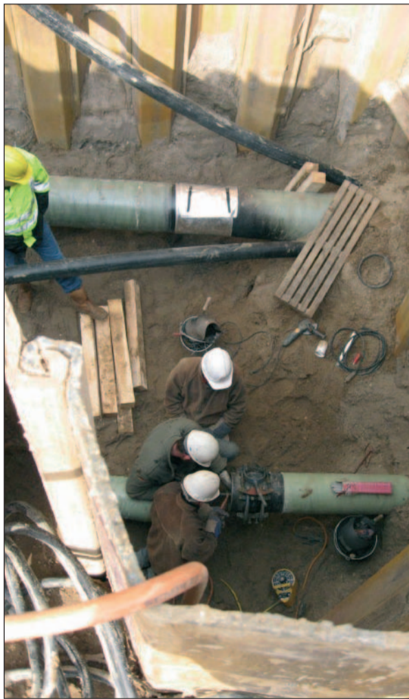
Die Bauarbeiter verlegen die Rohre (20. März)
