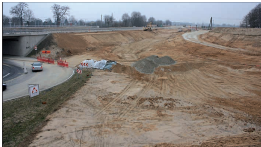
Riesige Erdmassen werden derzeit am Froschenteich bewegt.
