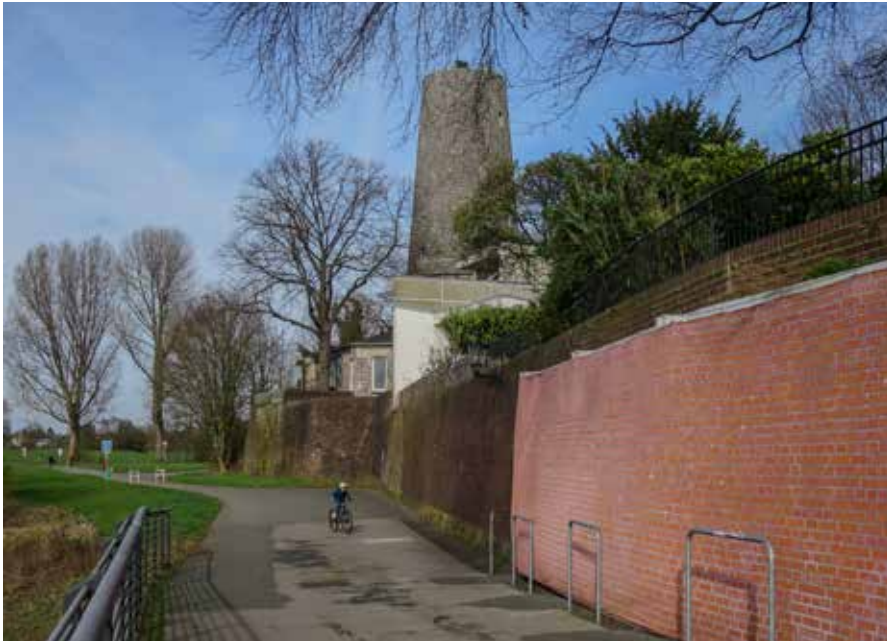
Ab Mai werden an der Kaiserswerther Hochwasserschutzmauer die Fugen erneuert und ein Betondeckstein aufgesetzt. Die Plane verdeckt eine Stützkonstruktion. Foto: hs
