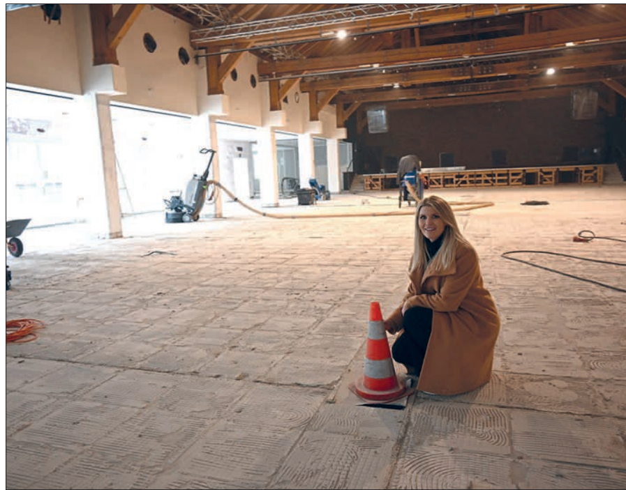
Stefanie Link, Geschäftsführerin Steinhof Vermarktungs UG, freut sich, dass die Bauarbeiten gut im Zeitplan liegen. Fotos: sam
