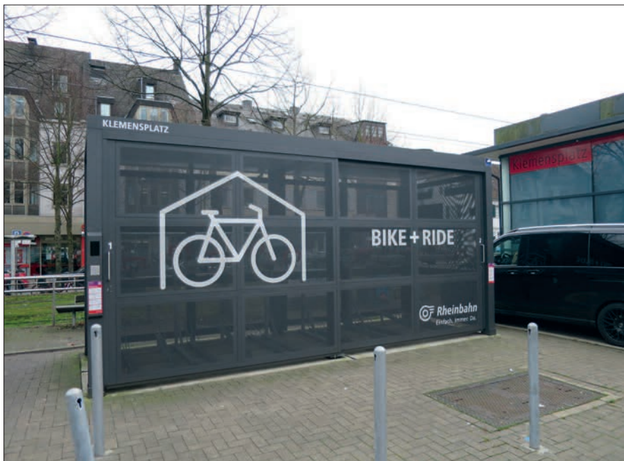
Sichere Abstellmöglichkeiten für Fahrräder gibt es in solchen Fahrradgaragen in Wittlaer und am Klemensplatz in Kaiserswerth. Foto: HS
