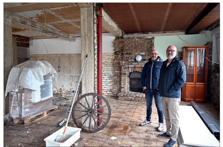
Die Kölner Unternehmer Burcin Dereli (rechts) und Daniele Ungaro bauen mit viel Elan das ehemalige „Haus Will“ zu einem Aparthotel um. Derzeit wird das ehemalige Restaurant entkernt. Der Kamin soll erhalten bleiben. Foto: sam
