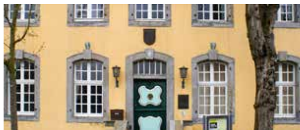
Die WC-Anlagen des Angermunder Bürgerhauses werden saniert. Foto: cj
