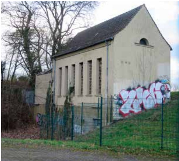
Das alte Pumpenhaus auf dem Kaiserswerther Deich von der weniger verschmierten, noch eingezäunten Seite. Archivfoto: hs
