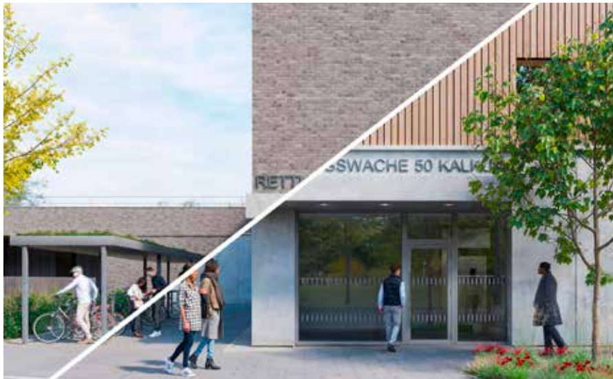
Die Visualisierung zeigt die beiden Fassadenvarianten für die neue Rettungswache 50 Kalkum mit Klinkerverblendung (links) und der Holz-Beton-Struktur (rechts). Visualisierung: IPM
