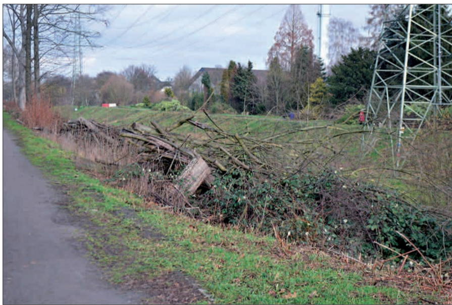
Um die Standsicherheit des Deiches auch im Hochwasserfall zu gewährleisten, mussten Am Neuen Angerbach 85 Bäume gefällt werden – so die WBD.
