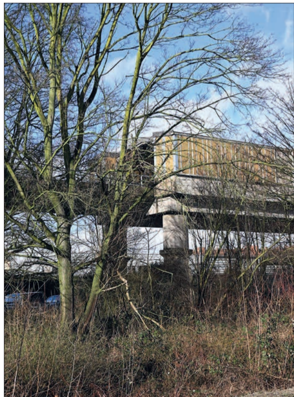
Der Stadtbahnhof „Huckingeng- Angerbogen“ ist ein reiner Durchfahrbahnhof für die U 79. Er soll jetzt für 2,3 Millionen Euro komplett saniert werden. Foto: sam
