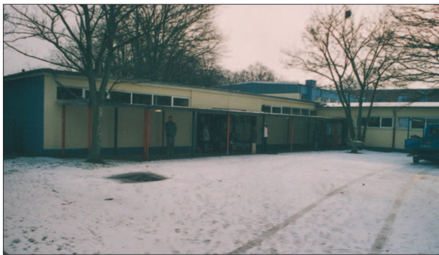
In der Gerhard-Tersteegen-Grundschule am Freiligrathplatz muss der abgebildete eingeschossige Pavillon aufgestockt werden, damit ausreichend Platz für die Offene Ganztagsgrundschule ist (Betreuung der Kinder am Nachmittag). Text und Foto: HS
