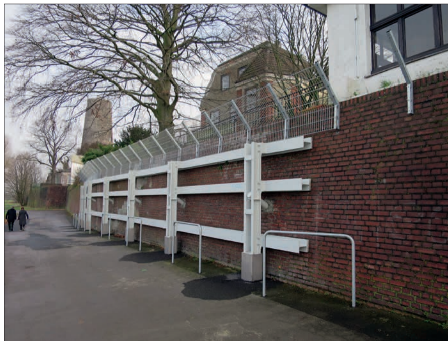
Auf der Kaiserswerther Rheinuferpromenade stellt sich die Frage, ist es Kunst oder ein Ingenieurbauwerk? Foto: H.S.
