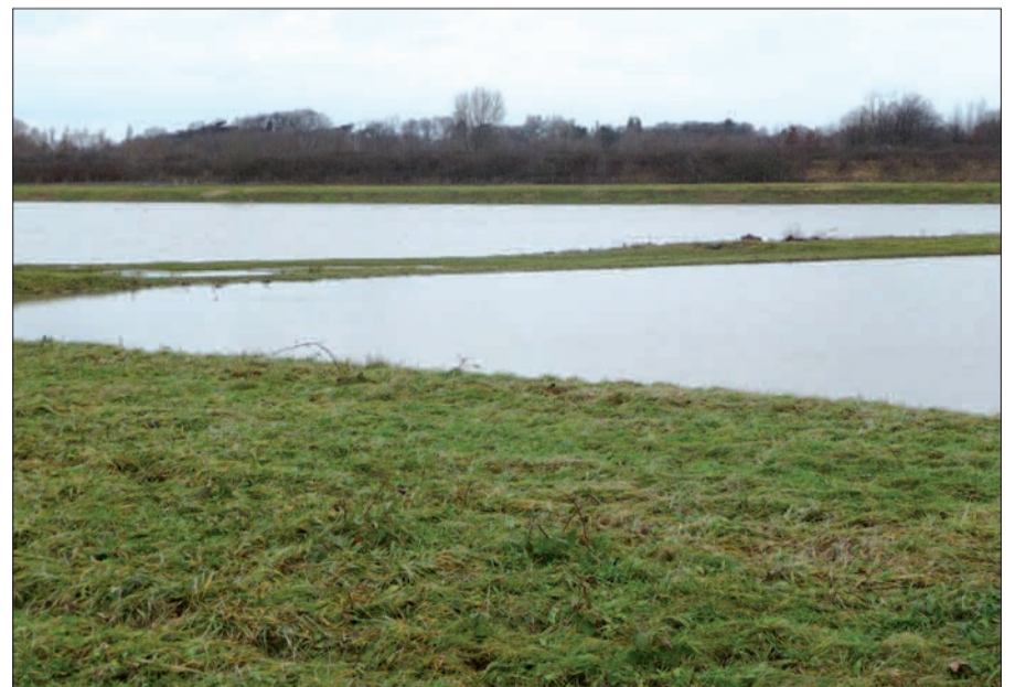
Ein völlig neues Landschaftsbild zeigen die beiden bis zum Rand gefüllten, großen Regenwasserrückhaltebecken in Zeppenheim zwischen Danziger Straße und Flughafen. Sie liegen ansonsten trocken. Das westliche Rückhaltebecken links im Bild ist noch gar nicht ausgebaut (Boden nicht abgedichtet) und eigentlich offiziell noch nicht nutzbar. Foto: H.S.
